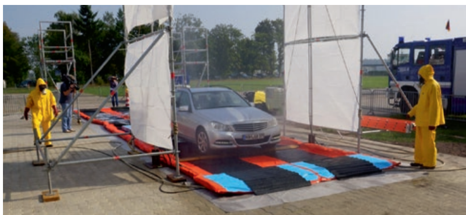
Desinfektionsschleuse für Fahrzeuge, wie sie die Tierseuchenlogistikzentren im Seuchenfall bereithalten.
